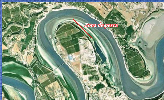
■ La imagen permite ver la planta de tratamiento de áridos y la zona de pesca.
